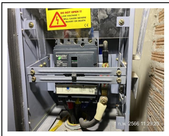
ภาพก่อนทำการบำรุงรักษาตู้ Distribution Board & Busduct Plug In
