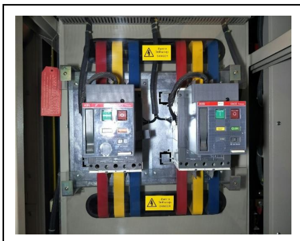
ภาพก่อนทำการบำรุงรักษาตู้ Main Distribution Board
