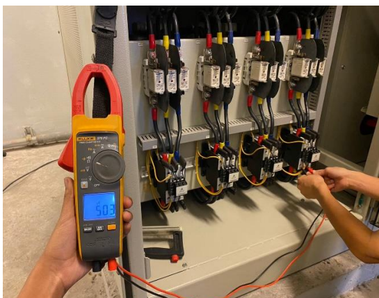
ภาพขณะทำการวัดค่า Capacitor Bank
