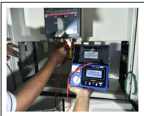
ภาพขณะทำการ INSULATION RESISTANCE TEST
